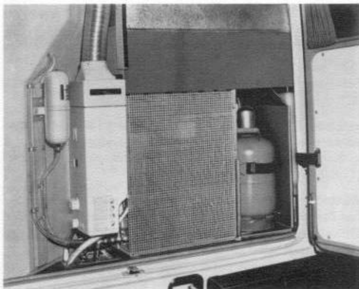
Ansicht bei geöffneten Hintertüren. Links Gasdurchlauferhitzer, rechts Gasflaschen.
